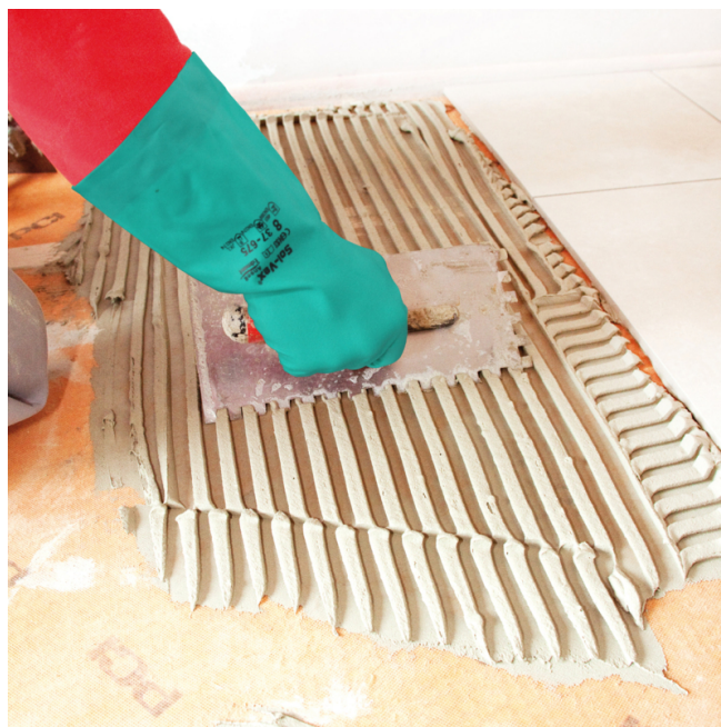
und mittels PCI Flexmörtel S1 Flott den neuen Keramikbelag verlegen.
