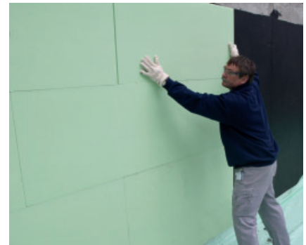
Einschieben der Styrodur ® Perimeterdämmplatten in das Kleberbett aus PCI Pecimor DK.
