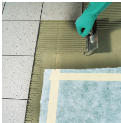
5. Anschließend keramische Beläge ohne Grundierung ...
