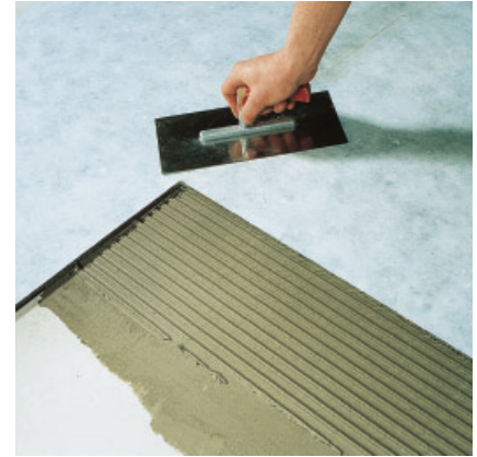
3. ... und mit einer Glättkelle andrücken.
