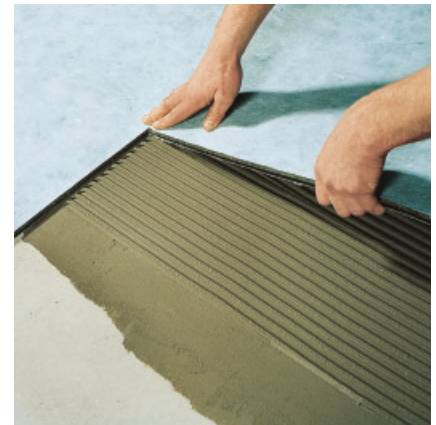
PCI Polysilent-Platten zur Trittschallminderung und zur Entkopplung von Keramik- und Naturwerksteinbelägen vom Untergrund.
