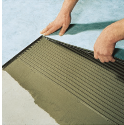
2. PCI Polysilent ins Mörtelbett einlegen (weiße Vlieskaschierung nach oben) ...
