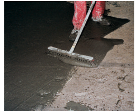
PCI Repahaft wird auf den Untergrund aufgebürstet. Der Estrichmörtel wird sofort danach auf die frische Haftbrücke aufgetragen.
