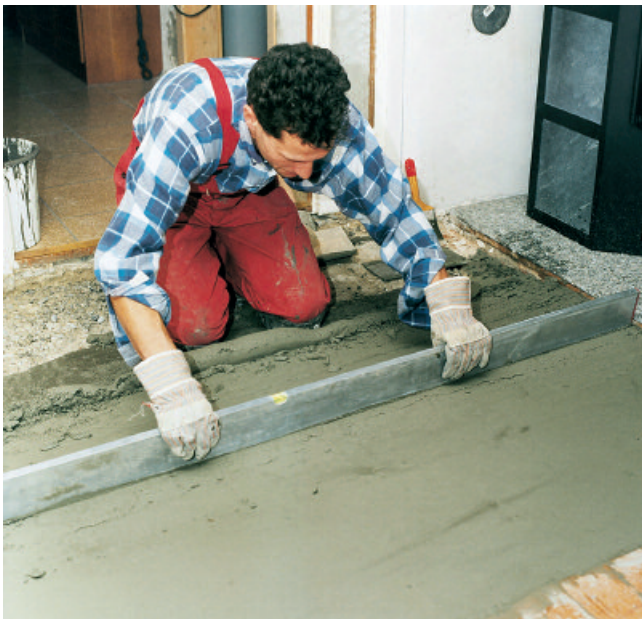
PCI Repament auf den vorbereiteten Untergrund in der gewünschten Schichtdicke einbringen und abziehen ...
