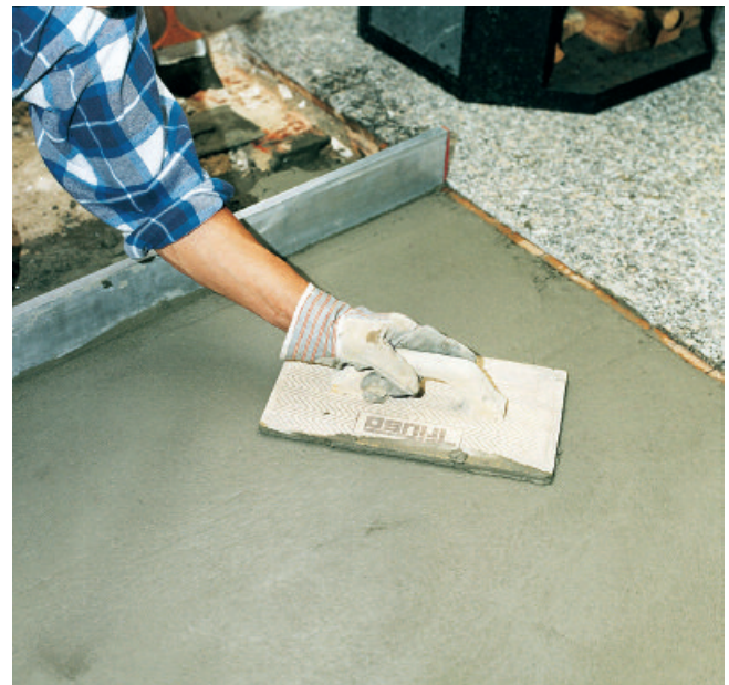
... mit einem Reibebrett verdichten und zureiben.
