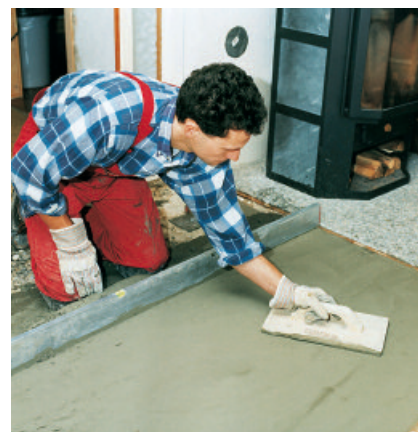
Die Fertigmörtelmischung PCI Repament härtet schwindungsarm und rissfrei aus.
