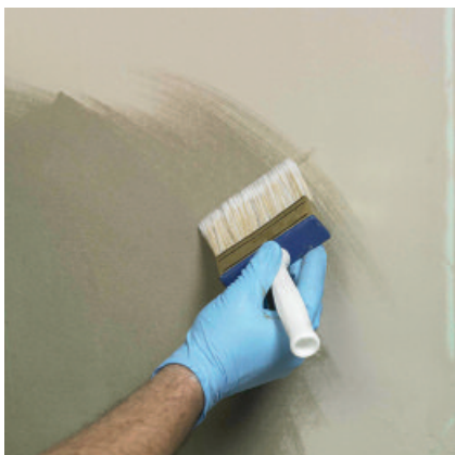
Untergrund mattfeucht vorbereiten.
