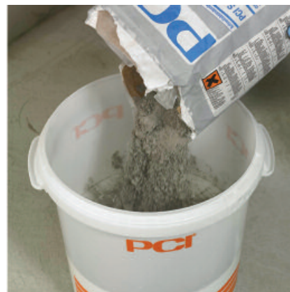
PCI Seccoral 2K Rapid Pulver dazugeben.
