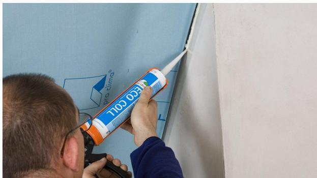
**9a. Anschluss an verputzten Schornstein (gedämmt oder 2-schalig)**
