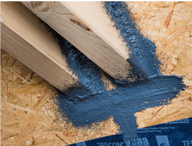
9. Fertig angeschlossene Zangendurchdringung
