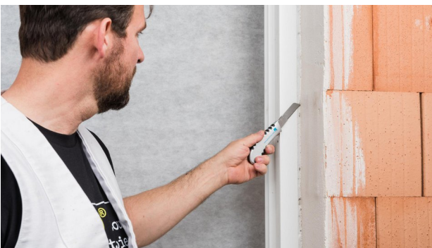
3. Dämmstoff abschneiden
