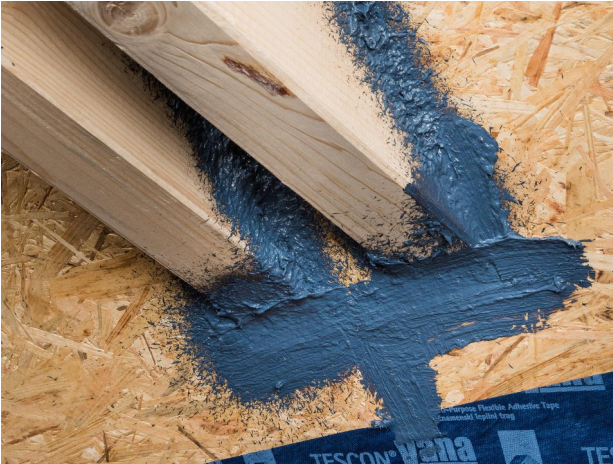
9. Fertig angeschlossene Zangendurchdringung
