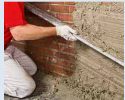
▲ 3. Abziehen Entfeuchtungsputz abziehen
