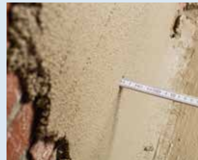
▲ 5. Messen Kontrolle der Schichtdicke
