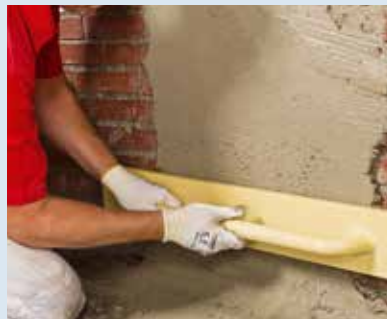
▲ 4. Glätten Sperrputz glätten oder filzen
