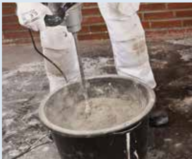
▲ 1. Anmischen Entfeuchtungsputz anrühren
