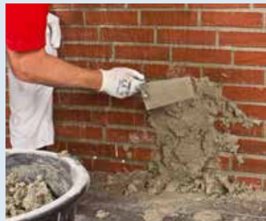
▲ 2. Auftragen Entfeuchtungsputz anwerfen
