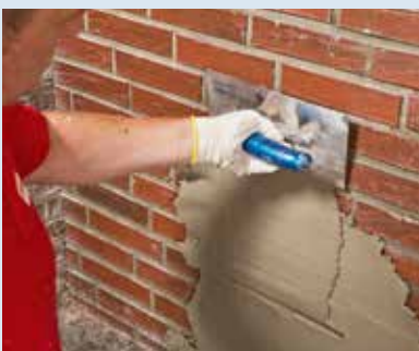
▲ 4. Glätten Entfeuchtungsputz glätten
