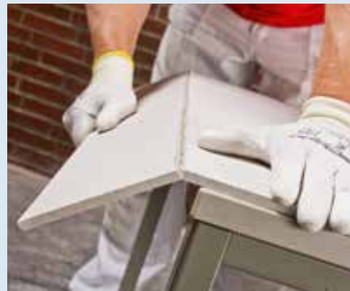
▲ 2. Zuschneiden Kellersanierplatte ritzen und brechen
