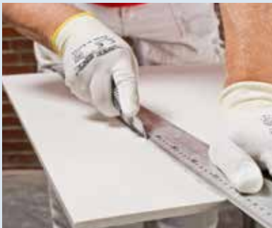
▲ 1. Ausmessen Kellersanierplatte ausmessen
