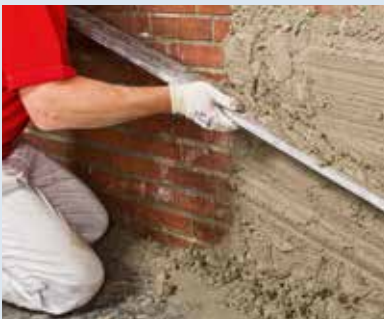
▲ 3. Abziehen Sperrputz abziehen
