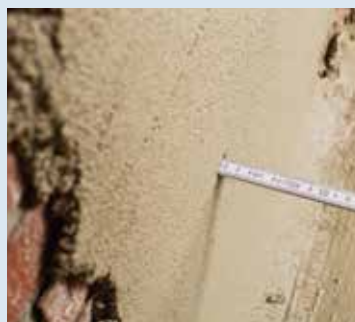
▲ 5. Messen Kontrolle der Schichtdichte
