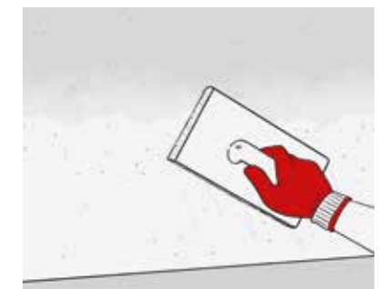
3. Glätten und Filzen Nach dem Auffüllen und Anziehen des neuen Putz wird der Übergang von alt zu neu angearbeitet.
