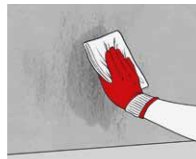
2. Schimmelpilz entfernen Den abgetöteten Schimmelpilz möglichst rückstandslos mit einem geeigneten Lappen o.ä. entfernen.
