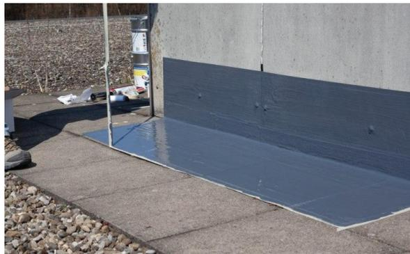
Fertigstellen der Zweitbeschichtung durch entfernen der Abdeckbänder.
