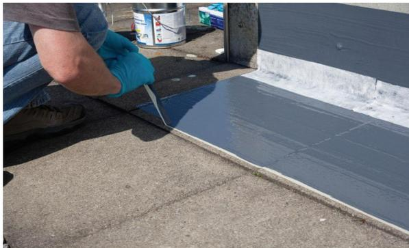
Fertigstellen der Erstbeschichtung durch Entfernen der Abdeckbänder innerhalb der Verarbeitungszeit von Gomastit Aqua Protect Flex liquid. Verbrauchsmenge Erstbeschichtung: ca. 1.5 kg/m<sup>2</sup> = ca. 1.0 mm Schichtstärke.
