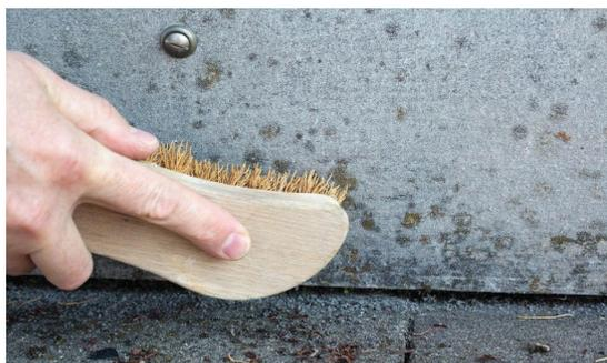
Eine gute Reinigung entscheidet über die Benetzung und Haftung von Gomastit Aqua Protect Flex liquid auf dem Untergrund und somit über den Erfolg (Dichtheit) der Abdichtung.
