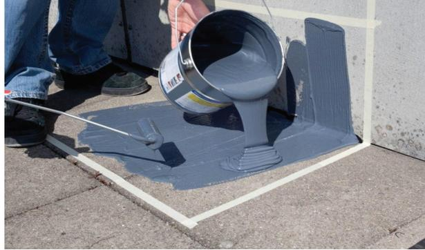
Das Auftragen von Gomastit Aqua Protect Flex liquid erfolgt entweder direkt aus dem Gebinde oder durch Entnahme mit Roller, Pinsel oder Spachtel. Hierbei muss aber beachtet werden, dass kein Schmutz ins Gebinde gelangt. Auftragsmenge Erstbeschichtung ca. 1.5 kg/m<sup>2</sup> = ca. 1.0 mm Schichtstärke.
