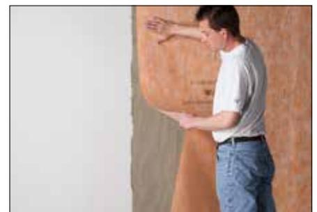
Schlüter-DITRA 25 ist eine Polyethylenbahn mit schwalbenschwanzförmig hinterschnittenen, quadratischen Vertiefungen, die rückseitig mit einem Trägervlies versehen ist. DITRA 25 dient in Verbindung mit Fliesenbelägen als Abdichtung, Dampfdruckausgleichsschicht bei rückwärtiger Feuchtigkeit und Entkopplungsschicht.
