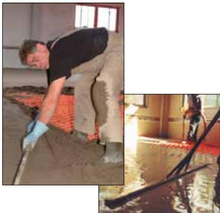
Vor Einbringen des Estrichs ist das Heizsystem durch eine Druckprobe auf Dichtheit zu überprüfen. Es ist sicherzustellen, dass keine Beheizung des Systems während der Einbringung und des Abbindeprozesses des Estrichs erfolgt.
