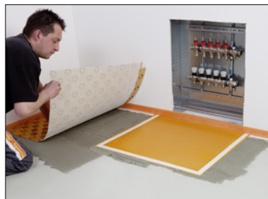
8 Verteilerbereich – beigefügte Doppelklebebander aufbringen und Estrichnoppenplatten EN 12 FK auf Ausgleichsplatte EN FGK verkleben.
