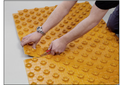
3 Verarbeiten der Estrichnoppenplatte – Schneiden zwischen den Noppen: mit scharfem Messer/ Cutter anschneiden ... und brechen.
