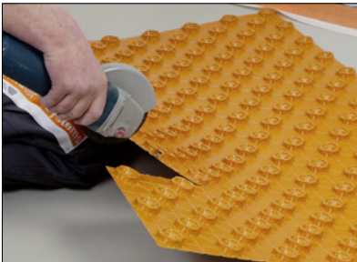
4 Verarbeiten der Estrichnoppenplatte – Schneiden im Noppenbereich: Winkelschleifer benutzen.
