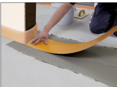
10 Türbereich – Ausgleichsplatte EN FGK (glatte Folienplatte) einpassen und mit Dünnbettmörtel verkleben. Ggf. an der Oberseite beigefügtes Doppelklebeband aufbringen.
