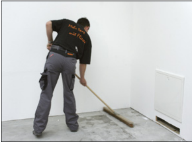
1 Reinigen des ausreichend tragfähigen und ebenflächigen Untergrundes.
