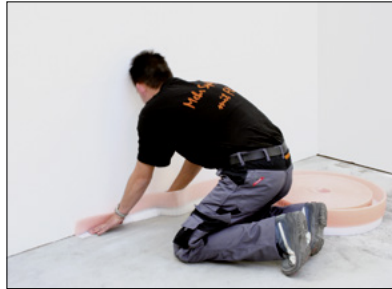
2 Einbau des Randstreifens BRS 505 KSF mit Klebestützfuß.
