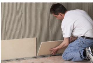
Schlüter®-KERDI-DS ist eine spezielle Polyethylenbahn als Verbundabdichtung und Dampfsperre mit einem  $s_d$ -Wert von größer 100 m, der bauphysikalisch als Dampfsperre gilt. Die Abdichtungsbahn ist 0,5 mm dick und mit wasserdampfsperrenden Additiven ausgestattet.
