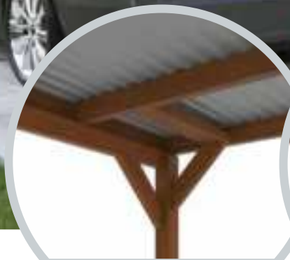
Sicht unter das Dach mit Aluminium-Dachplatten
