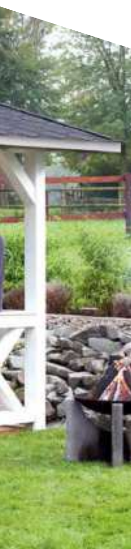
↑ CANNES 3 mit Brüstungen aus Andreaskreuzen*, Dachschindel*, Firstkappe* und farbliche Behandlung in weiß, Fußboden bauseits
