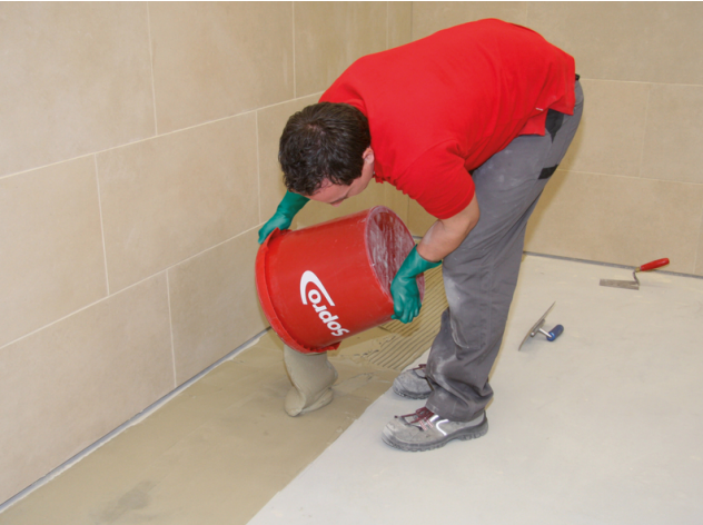
Ausgießen des FKM XL in Fließbettkonsistenz auf den vorbereiteten Untergrund.
