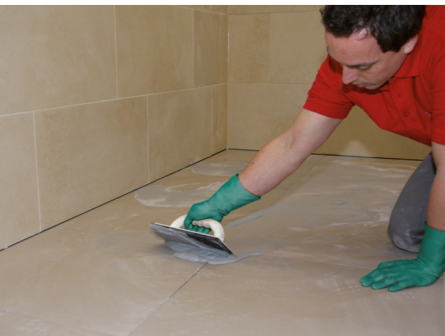
Verfugung der Fläche mit einer Sopro Fugenmasse (z.B. Sopro DF 10 DesignFuge Flex, Sopro Brillant Perlfuge)
