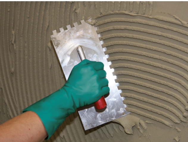
Aufziehen des Kammbettes in Wandkonsistenz auf die vorbereitete Kontaktschicht.
