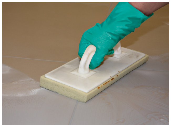
Abwaschen des Fliesenbelages nach ausreichender Standzeit der eingefugten Sopro Fugenmasse.
