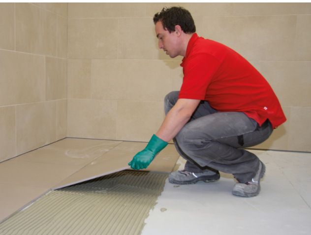
Großformatiges Feinsteinzeug einlegen und ausrichten. Fugennetz
