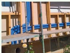
Auch der Einsatz von Wärmebrücken optimierten Stegträgern aus dem STEICO Bausystem stellt kein Problem dar.
