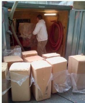
Die Ballen der Einblasdämmung werden in die Maschine eingefüllt.
