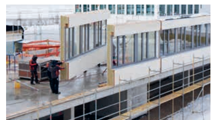
Die vorverputzten Wandelemente werden inklusive Fenster montiert.
