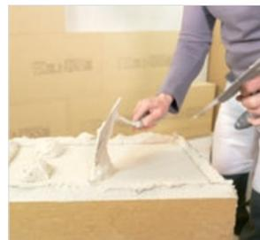
Dämmplatte ankleben auf unebenem Untergrund im Punkt-Wulst-Verfahren
