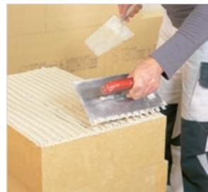
Dämmplatte ankleben auf ebenem Untergrund mit vollflächiger Verklebung
