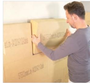
Verlegung kleinformatiger stumpfer Platten
