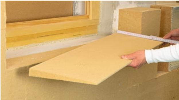
**1** Bündiger Zuschnitt des STEICOtri Holzfaser-Dämmkeils auf die passende Länge und Tiefe der Fensteröffnung
