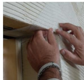
Im Bereich des Fenstersturzes bieten die Sturzeckwinkel eine Möglichkeit, um auch in der Innenecke der Laibung eine ausreichende Armierung sicherzustellen.
