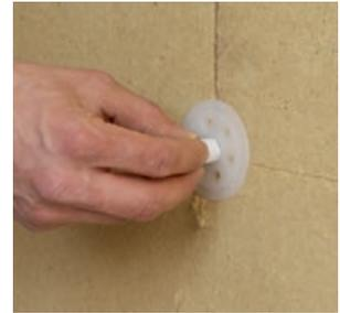
Zusätzlich zur Verklebung mit dem mineralischen Klebe- und Armierungsmörtel STEICOsecure Base muss eine Befestigung der Holzfaser-Dämmplatten mit Schraubdübel ejothem® STR U 2G im Mauerwerk erfolgen. Entsprechend der jeweils vorliegenden Windbelastung ergibt sich ein entsprechendes Dübelbild.
