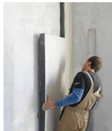
Wand- und Bodendämmung mit EPS
