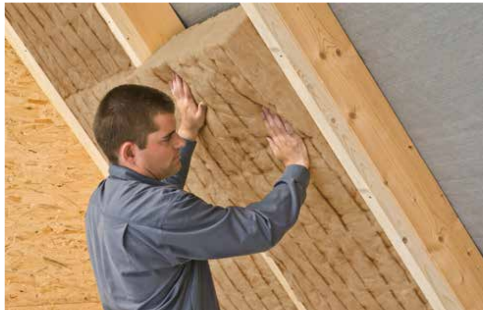
Steildachdämmung mit Glaswolle
