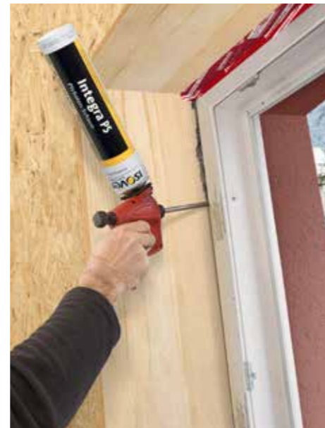
Gedämmter und luftdichter Anschluss
