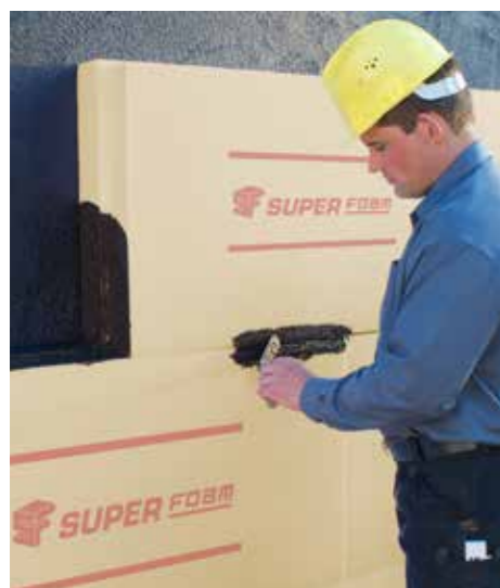
Perimeterdämmung mit XPS + KMB
