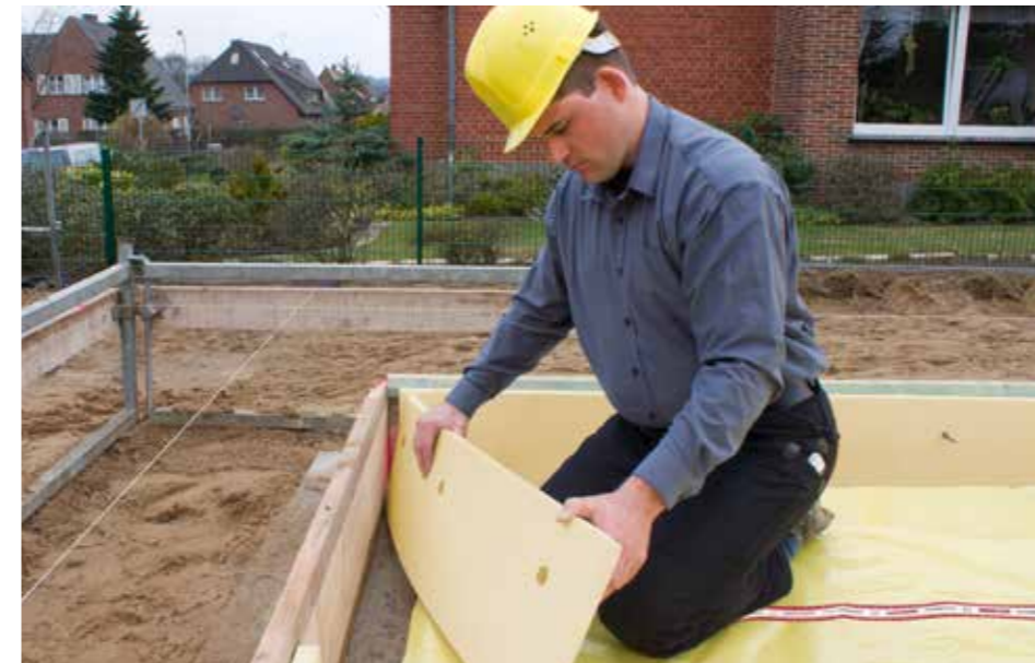
Wärmebrückendämmung an der Stirnseite der Betonbodenplatte
