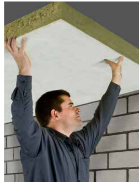
Deckendämmung mit Steinwolle
