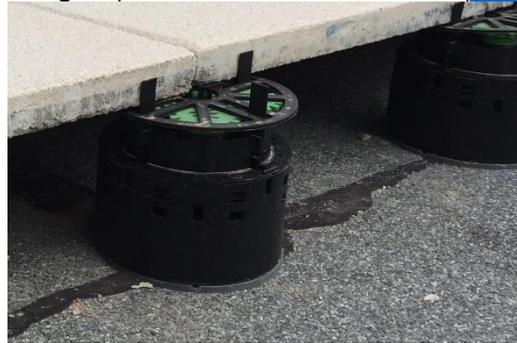
Abbildung 5: Anwendungsbsp. VOLFI-ZRV35 mit VT-A 2,5 aufgelegt. Als Erhöhung VT-U50, 2x VT-B und als Entkopplung VP-GKU untergestellt. Gesamthöhe Aufbau: 122,5 -137,5 mm
