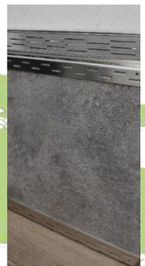
Abbildung 3: Einklicktes Drainrost zum Verdecken der Schraubenköpfe
