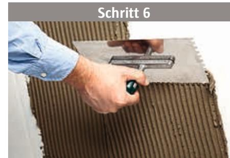
Verteilen Sie den Kleber mit einer Zahnkelle auf eine nicht zu große Fläche, damit er nicht austrocknet, bevor Sie die Steinriemchen verarbeitet haben. Es wird von unten nach oben gearbeitet. 8 mm Zahnung für Granulit Riemchen und 10 mm Zahnung für Murok Riemchen.
