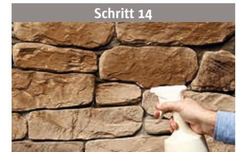
Schützen Sie Außenwände und Feuchträume immer mit Silifin Imprägnierung. Die Wand muss absolut trocken sein. Tragen Sie die Silifin Imprägnierung mittels Sprühflasche oder Quast auf. Die Steinriemchen müssen vollständig gesättigt sein.
