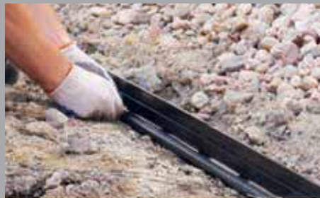
Anbringung von Strom- oder Bewässerungsleitungen ohne zusätzliche Elemente.
