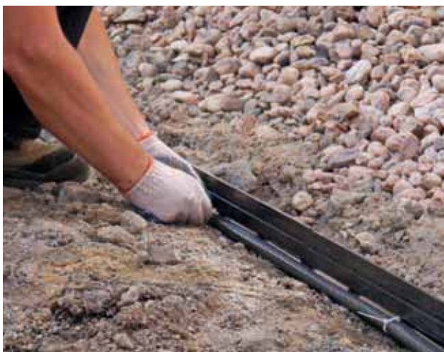
Saubere Verlegung von Kabel/Schlauch
