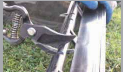
Durch Entfernen der Koppler kann das Profilelement biegsam gemacht werden.
