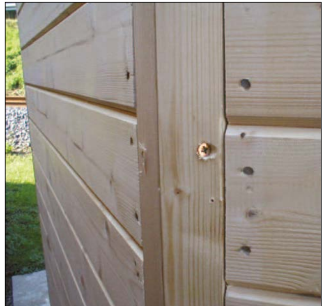
Außenansicht der montierten Wandecken (welche nach Auflage des Daches verblendet werden)
