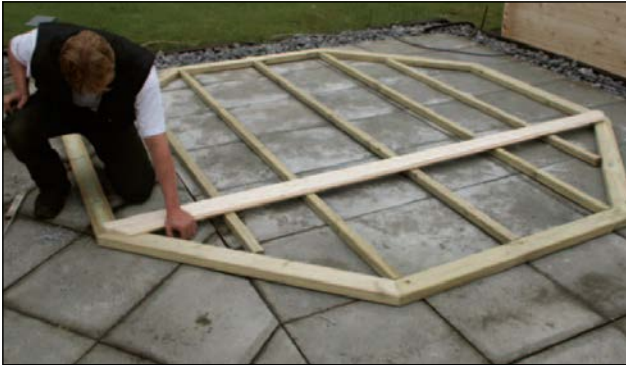
Abb. 11 Die Fußbodendielen sind bereits auf Maß geschnitten und brauchen nur bündig mit der äußeren Kante verlegt werden.
