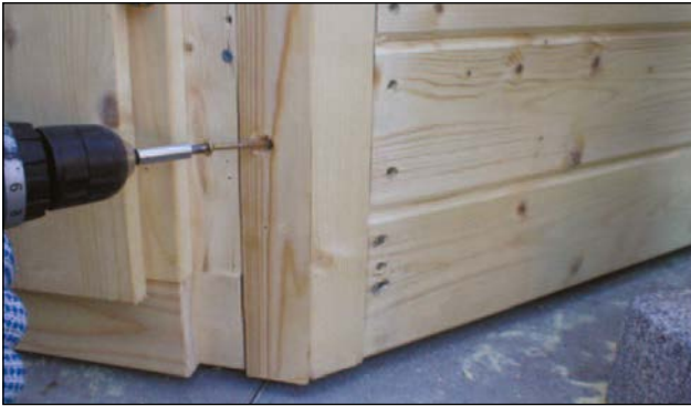
Abb. 16 Die einzelnen Wandelemente werden (innen bündig) von außen 4 bis 5 mal miteinander verschraubt. (Schrauben 5 x 90, Abbildung 10 und 11) Nach kürzester Zeit ist der Korpus aufgebaut.
