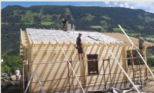
Auf die Unterspannbahn kommt die Dachlattung. Sie wird an den Sparren befestigt.
