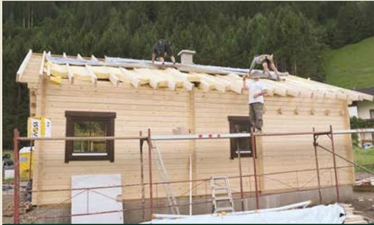
Auf die Sparren mit der Dämmung wird nun die Unterspannbahn aufgebracht.
