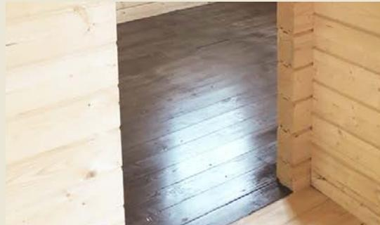
In allen Räumen und im Schlafboden wurden 280 mm starke Dielen mit Nut und Feder verlegt. Wir haben die Dielen jedoch verschraubt und nicht genagelt, damit man evtl. später mal Zugang zu den Elektroleitungen hat.
