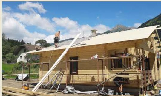
Die Dachpaneele werden angebracht.
