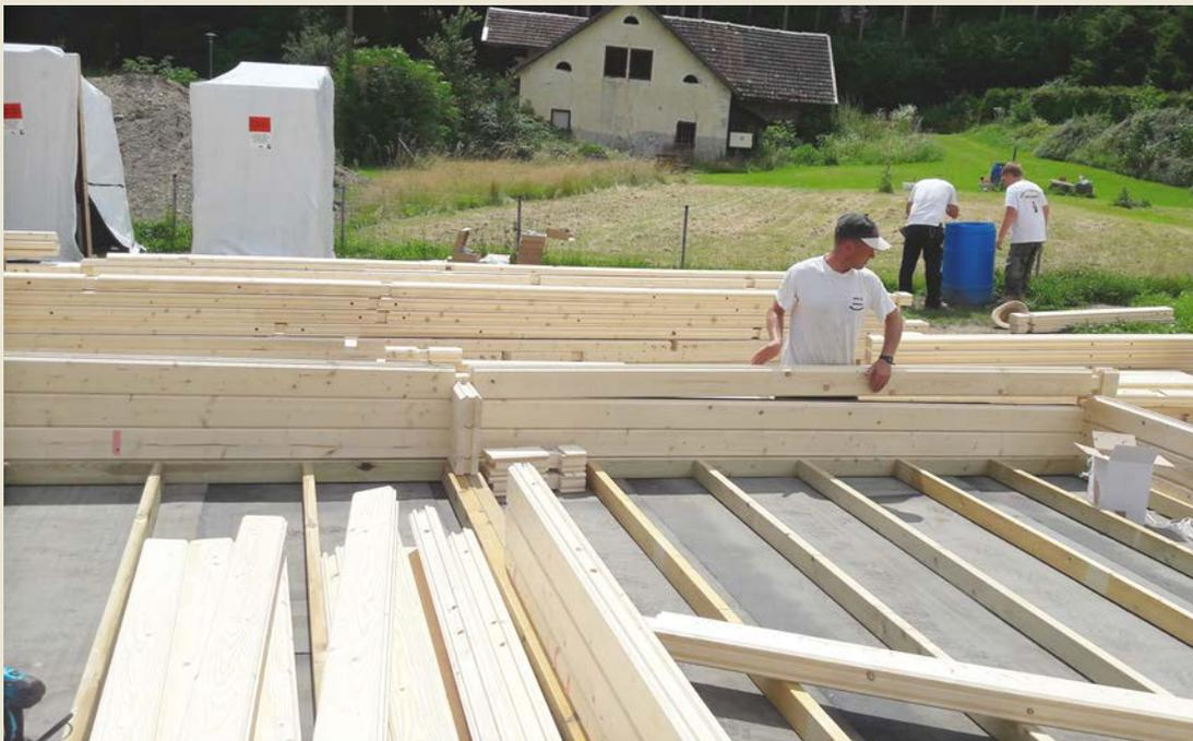
Nachdem die druckimprägnierte Lagerholzkonstruktion verbaut und verschraubt wurde, wurden nach ca. 1 Stunde schon die ersten Bohlenlagen aufgebaut. Alles war gut durchnummeriert und dem Plan gut zuzuordnen. Das Montageteam war routiniert und konnte zügig arbeiten.
