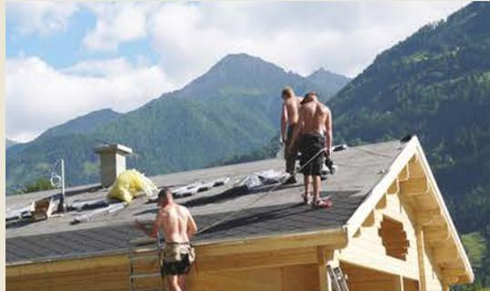
Jetzt können die Bitumenschindeln auf der Dachpappe verklebt werden.
