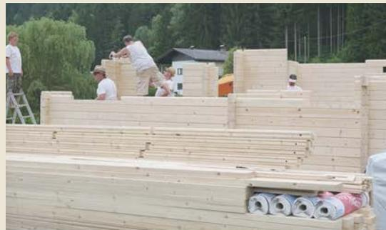
Bereits nach wenigen Stunden stand das Haus mit allen Wänden zwei Meter hoch. Fenster und Türen waren schon zu erkennen.
