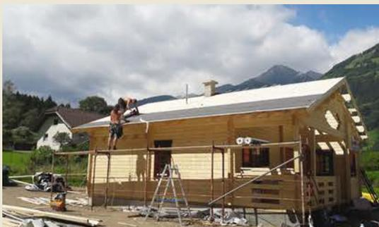
Auf den Dachpaneelen wird die Dachpappe verlegt.
