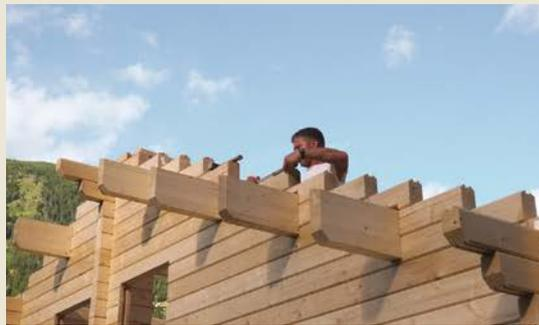
Alle Bohlen sitzen und sind durch die innenliegenden Gewindestangen verschraubt und durch eine Mutter zum nachjustieren fest miteinander verbunden. Alle Fellen wurden per Hand eingebaut und perfekt eingefügt. Im nächsten Schritt werden die Sparren angebracht.
