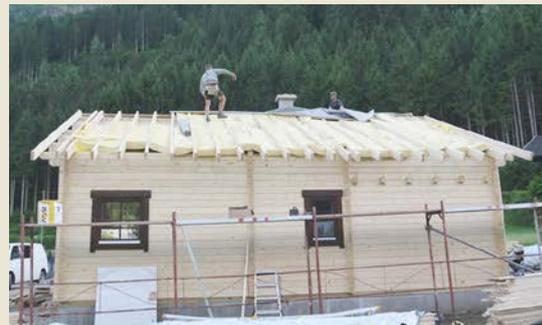
Das Dach wird mit einer Dampfsperre abgedichtet und ist erst einmal regendicht. Im Anschluss daran werden die Sparren montiert. Hier wurden 25 Sparren auf jeder Seite verbaut. Sie sorgen für extra Stabilität bei schwerer Schneelast im Winter. Für die Dämmung des Daches haben wir uns für eine Zwischensparren-Dämmung entschieden.
